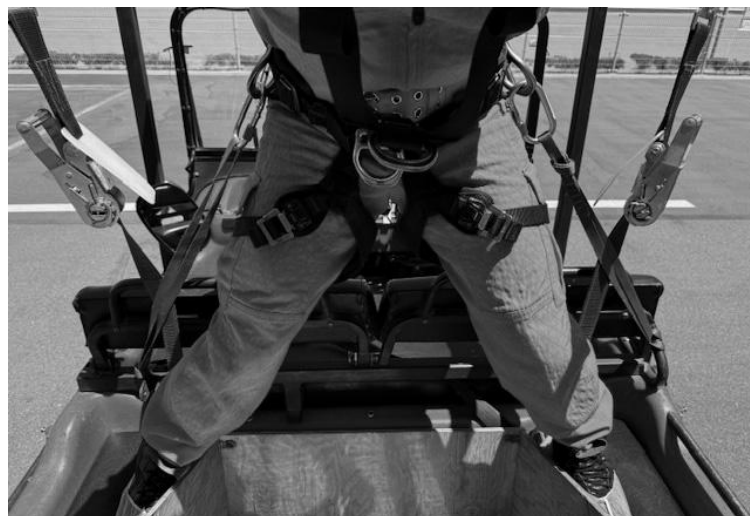
(写真12) 延長補助員の身体固定
